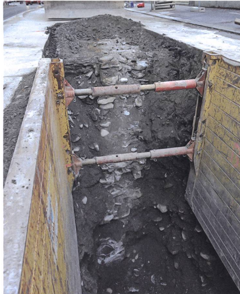
Abb. 2: Chur, Grabenstrasse. 2017. Anzug von 7–8 Grad und grosse Tiefe der «Contrescarpe-Mauer». Blick gegen Süden.
