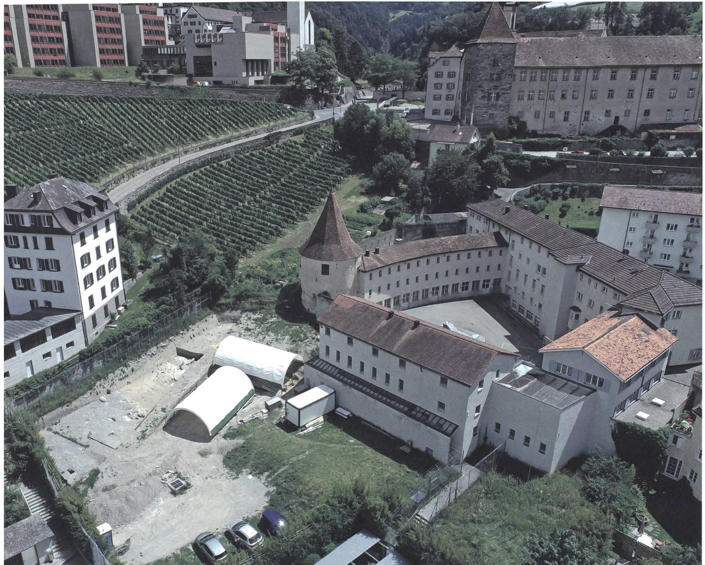
Abb. 1: Chur, Areal Sennhof. 2020. Übersicht der Grabungsfläche. Die Arbeiten in den östlichen Feldern sind bereits abgeschlossen. Blick gegen Süden.
