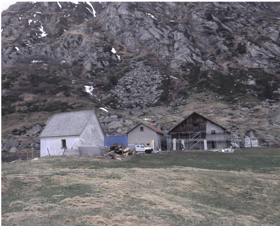
Abb. 1: Medel (Lucmagn), Alp Sogn Gagl. 2020. Das Alpgebäude/Hospiz mit Stall und Kapelle während den Umbauarbeiten. Blick gegen Westen.
