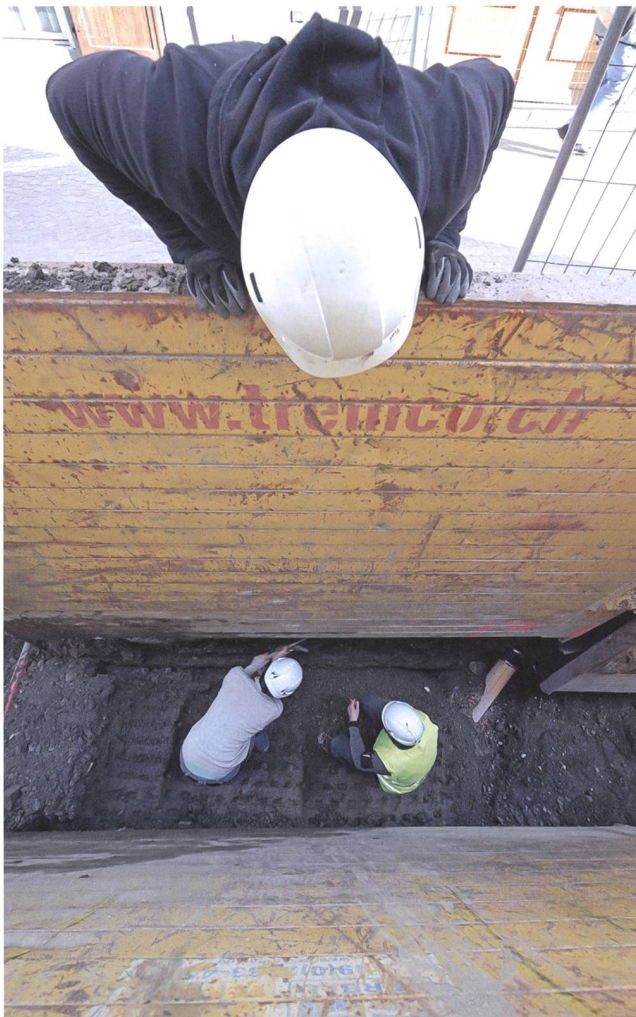
Abb. 1: Chur, Martinsplatz. 2020/2021. Arbeitssituation in den Kanalgräben.
