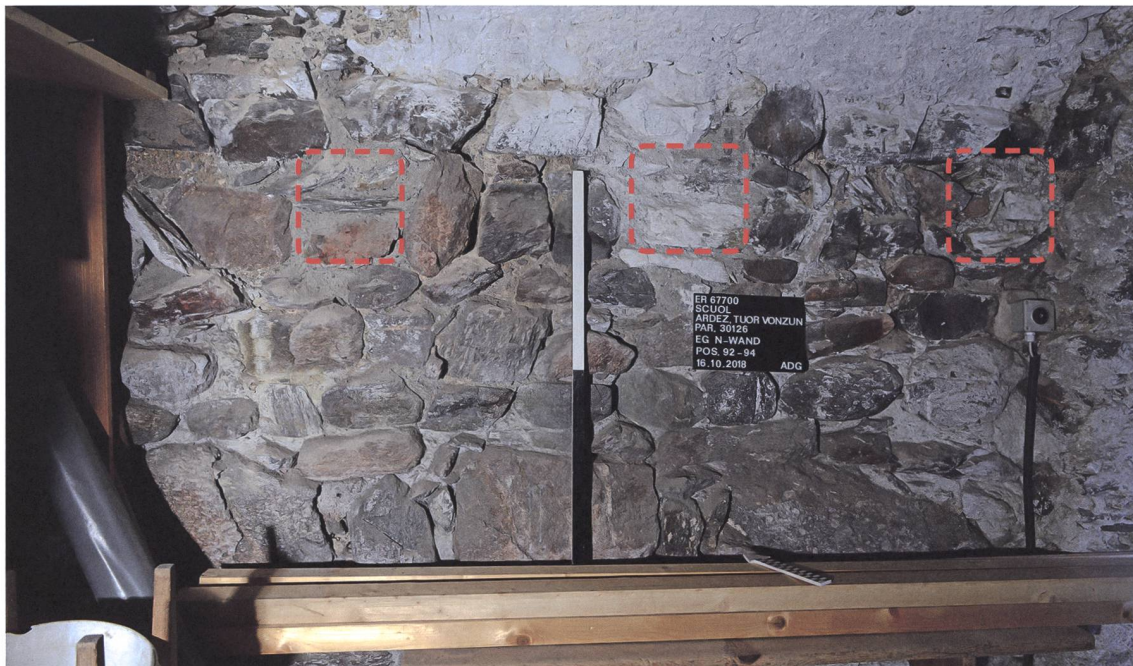
Abb. 3: Scuol. Ardez, Tuor Vonzun (La Präschun). 2018. Neu entdeckte, kaum mehr erkennbare Balkenlage der ursprünglichen Geschosseinteilung des Turmes. Blick gegen Norden.
