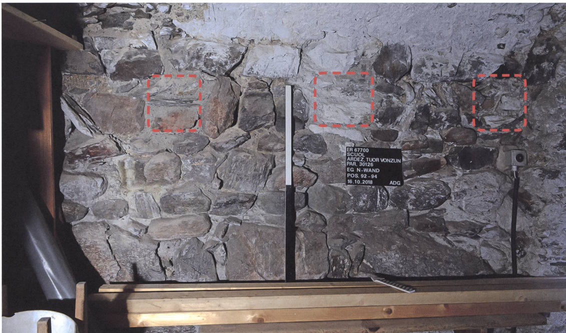
Abb. 3: Scuol. Ardez, Tuor Vonzun (La Praschun). 2018. Neu entdeckte, kaum mehr erkennbare Balkenlage der ursprünglichen Geschosseinteilung des Turmes. Blick gegen Norden.
