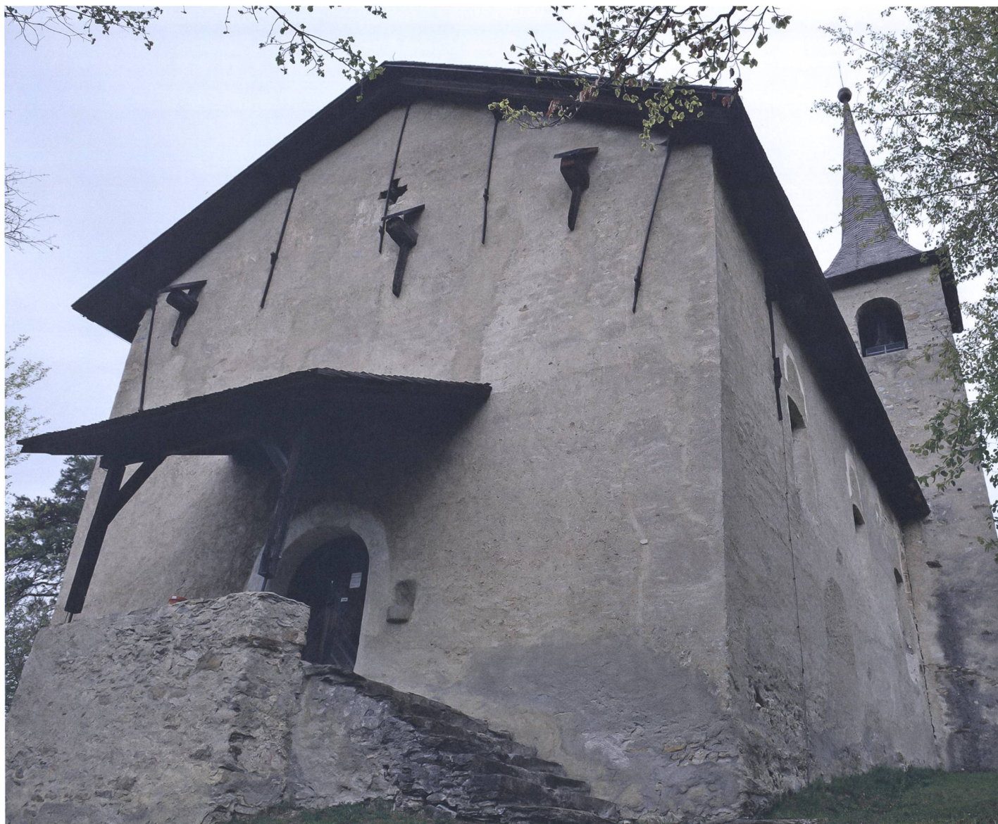
Abb. 8: Rhäzüns, Sogn Gieri. 2019. Westpartie der Kirche mit aktuellem Hauptportal und Treppenanlage. Blick gegen Nordosten.
