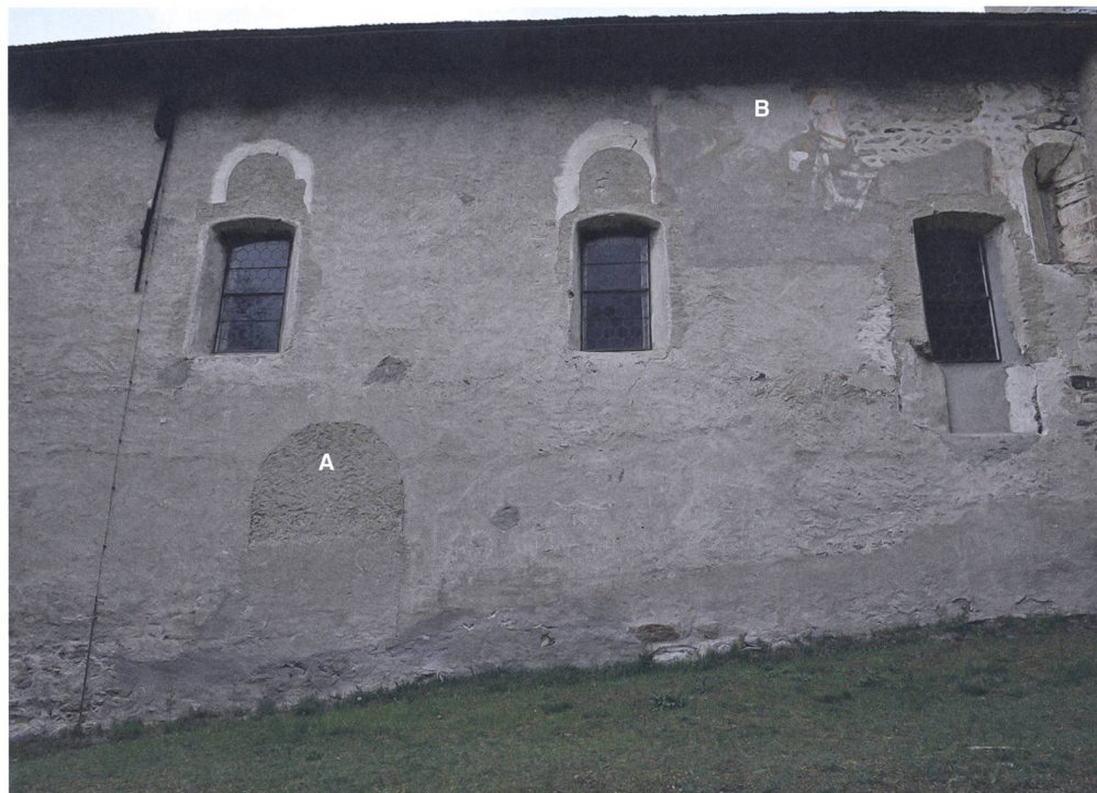
Abb. 6: Rhäzüns, Sogn Gieri. 2019. Südfassade des Schiffes. Teilweise zugemauert sind die älteren, originalen Fenster und der ursprüngliche Haupteingang A . Auf dem originalen, in Pietra-Rasa -Manier verputzten Mauerwerk liegen Reste eines Freskos B , welches den Drachenkampf des Heiligen Georgs darstellt (14. Jahrhundert). Blick gegen Norden.
