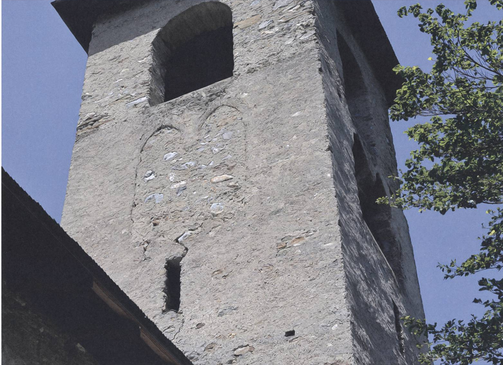
Abb. 7: Rhäzüns, Sogn Gieri. 2019. Der Glockenturm mit älteren und aktuellen Schallöffnungen. Blick gegen Nordosten.
