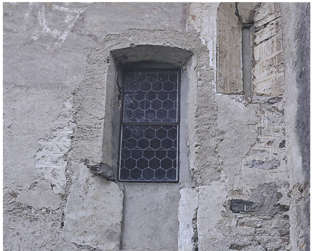
Abb. 32: Rhäzüns, Sogn Gieri. 2019. Ausschnitt der Südfassade des Schiffes mit sichtbarem älterem Mauerwerk und rundbogigem Schiffsfenster von Bau IV. Bildmitte: Jüngerer, mehrfach verändertes Fenster. Blick gegen Norden.
