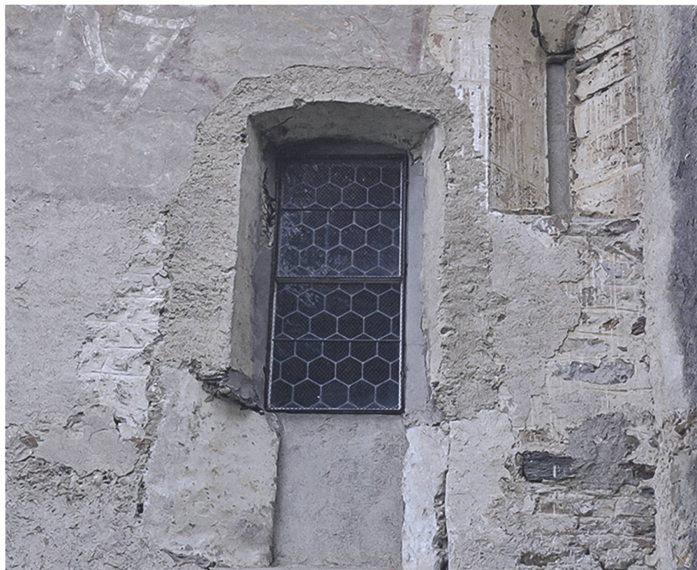
Abb. 32: Rhäzüns, Sogn Gieri. 2019. Ausschnitt der Südfas- sade des Schiffes mit sichtba- rem älteren Mauerwerk und rundbogigem Schiffsfenster von Bau IV. Bildmitte: Jünge- res, mehrfach verändertes Fenster. Blick gegen Norden.
