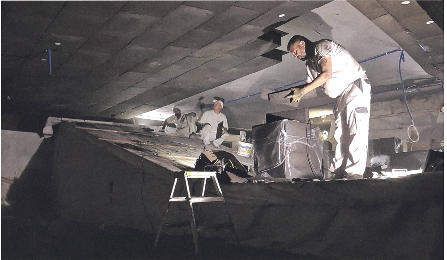
Abb. 4: Chur, St. Stephan. Montage der Foamglasdämmung am 9. Juli 2021.
