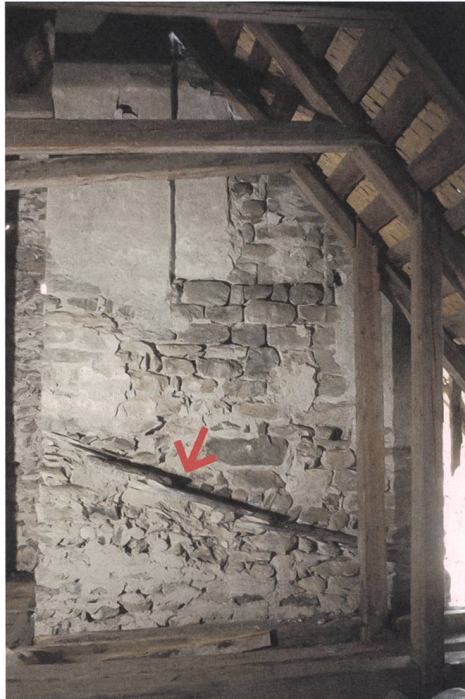
Abb. 13: Breil/Brigels, Sogn Sievi. 1970–1972. Dachgeschoss. Eine Reihe vorkragender Steinplatten (Pfeil) an der Turmostwand zeigt die Dachneigung von Bau I an. Blick gegen Westen.
