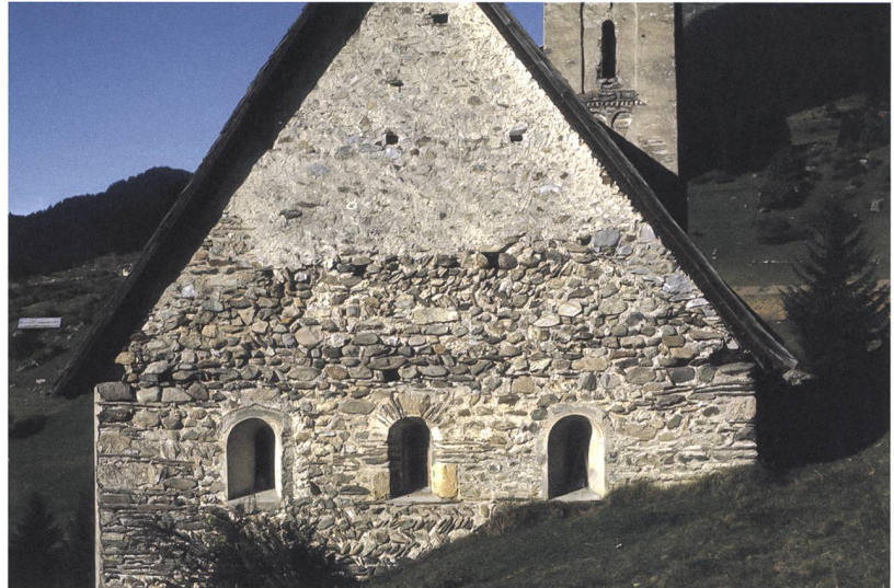
Abb. 7: Breil/Brigels, Sogn Sievi. 1970–1972. Stellen- weise unverputzte Ostfas- sade. Zu beiden Seiten des originalen Rundbogenfens- ters wurden nachträglich zwei weitere Fenster ein- gebrochen. Heute sind die beiden jüngeren Fenster wieder zugemauert. Blick gegen Westen.
