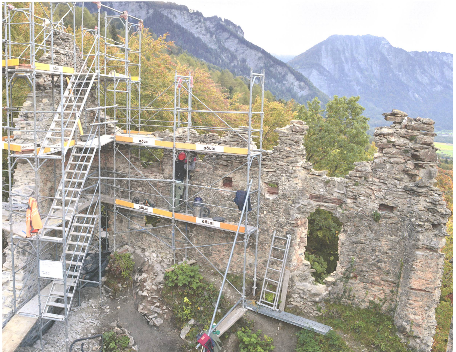
Abb. 1: Malans, Burganlage Wynegg. 2016. Sanierung der Südostmauer. Blick gegen Osten.
