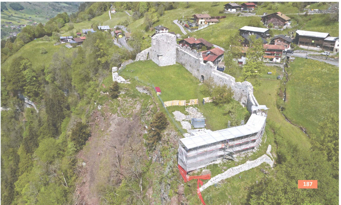
Abb. 1: Luzein. Luzein, Putz, Buranlage Castels. 2015/2016. Sanierungs- etappe des östlichen Wehr- mauerabschnitts. Blick ge- gen Nordwesten.
