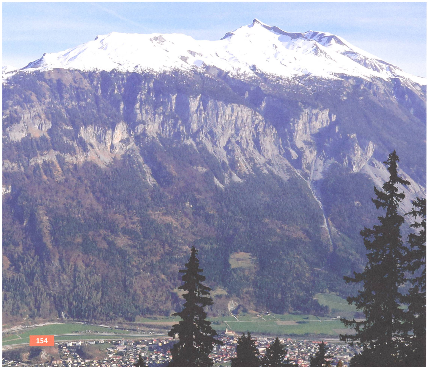
Abb. 1: Felsberg, Calanda. 2016. Am Südhang liegt das Gebiet mit den Stollen. Blick gegen Norden.
