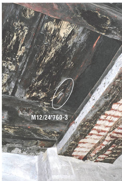
Abb. 6: Val Müstair. Kloster St. Johann in Müstair, Heiligkreuzkapelle, Untergeschoss. Eine der Probenentnahmestellen an der karolingischen Deckenbohle.
