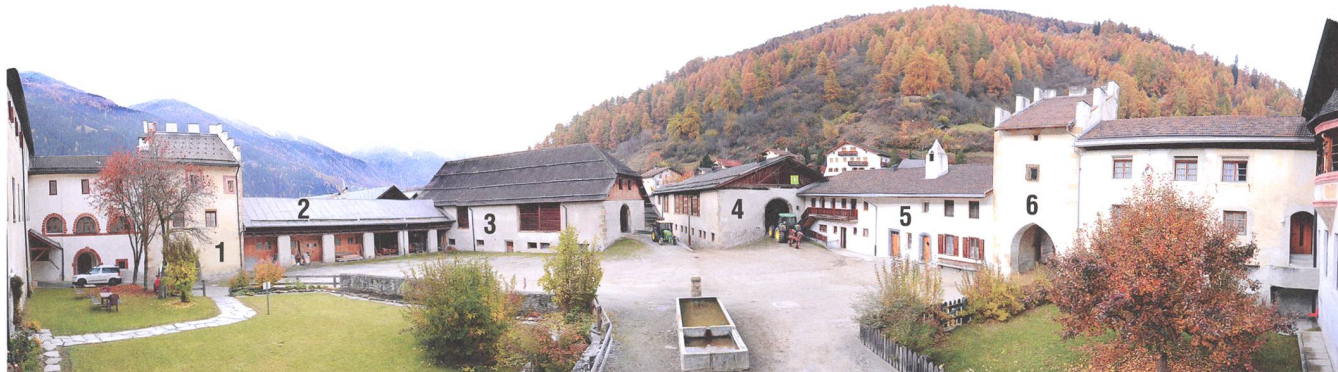
Abb. 7: Val Müstair. Kloster St. Johann in Müstair. Panorama des Westhofs/Wirtschaftshofs. Blick gegen Westen.
