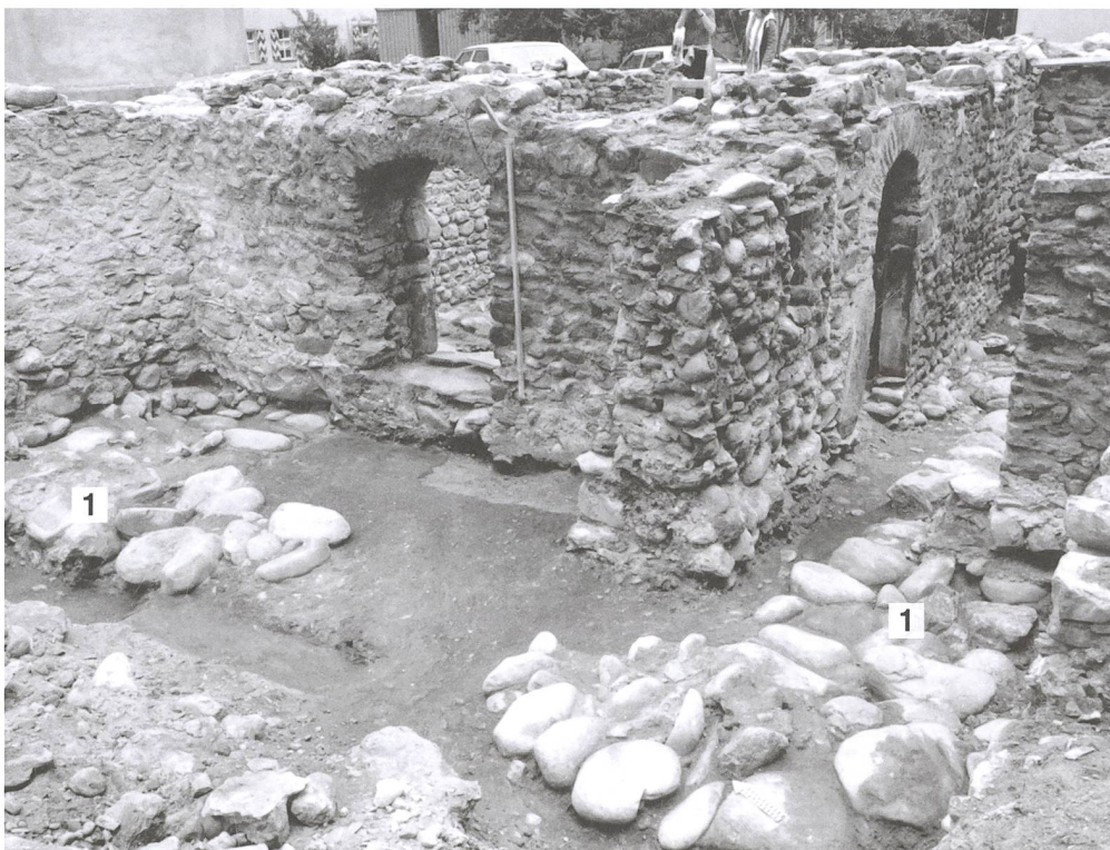
Abb. 16: Ilanz/Glion. Ilanz, Haus Cavegn. 1984. Das mittelalterliche Kellergeschoss konnte beim Neubau erhalten werden. Unter dem Kellerboden erscheinen die Fundamente 1 eines älteren Bauwerks mit wehrhaftem Charakter. Blick gegen Nordosten.
