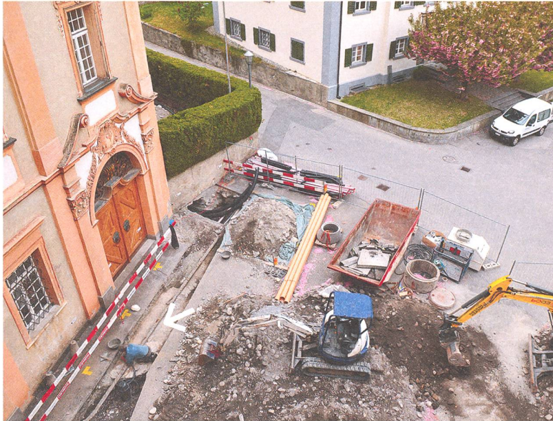
Abb. 2: Chur, Hof, Hofplatz Bischöfliches Schloss. 2013. Vor der Westfassade des Bischöflichen Schlosses ist das Fundament des gotischen Turmes (Pfeil) partiell freigelegt. Blick gegen Osten.
