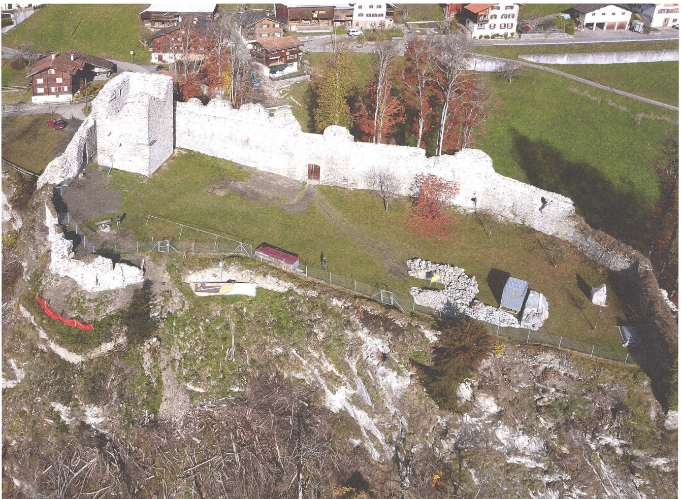
Abb. 1: Luzern, Putz, Burganlage Castels. 2015. Die in den Jahren 2011–2014 restaurierten Mauerabschnitte heben sich deutlich von den noch ungesicherten Partien ab. Blick gegen Norden.
