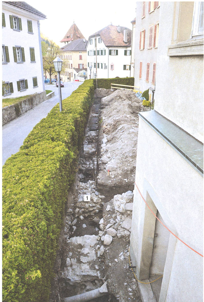
Abb. 1: Chur, Hof, Bischöfliches Schloss, Südgarten. 2013. Im Graben für die Fernwärme ist die Mauer der spätantiken Befestigung 1 freigelegt. Blick gegen Westen.
