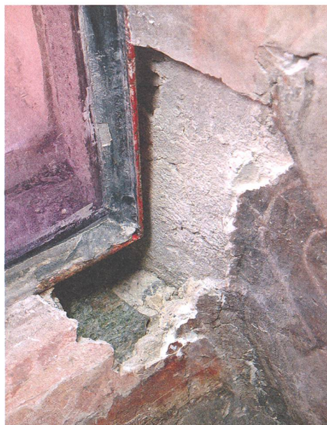
Abb. 4: Val Müstair. Kloster St. Johann in Müstair, Klosterkirche, Südapsis. Südlaibung und Sohlbank des Scheitelfensters mit den Befunden zur karolingischen Fensterbauweise: Laibungsschräge – Mörtelüberzug – Sohlbankmauerung – Stockeinbau – dazu Dichtungsmörtel – Laibungsmalerei – Sohlbankmalerei.
