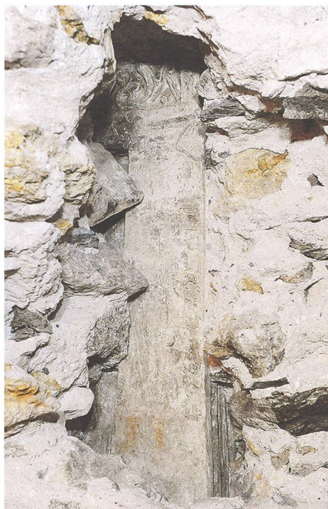
Abb. 7: Val Müstair. Kloster St. Johann in Müstair, Nordannex 5, Südwand, Taferelief. Rückseite des glatten, westlichen Abschlusspfeilers am Taferelief. An der Westseite mit Kanneluren und oben mit einer Volute versehen, stützt er den Architrav mit Blattkymation. Links des Pfeilers ist noch knapp die vertiefte, unverzierte Füllung zu sehen. Blick in die Sondierung gegen Südosten.
