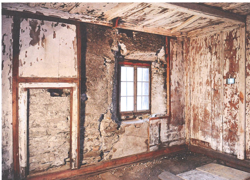
Abb. 13: Val Müstair. Kloster St. Johann in Müstair, Nordtrakt, Castelmurkammer 85. Nordwand ohne das spätgotische Täfer. Blick gegen Nordosten, nach der Bauuntersuchung.
