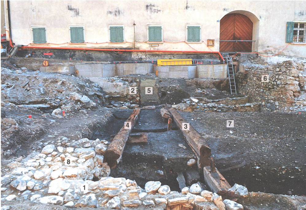
Abb. 4: Chur, Bischöfliches Schloss, östlicher Aussenbereich. 2012. 1 Ostmauer Weiher 2 Nordmauer Weiher 3 Kantholz wand, dendrodatiert 1540/42. 4 Kantholz wand, dendrodatiert 1664. 5 Lehmverfüllung. 6 Stützmauer. 7 Verfüllung. 8 Strebebefeiler zur Ostmauer Weiher. Im Hintergrund das Weiherhaus mit den fünf Schachtfundamenten. Blick gegen Südwesten.
