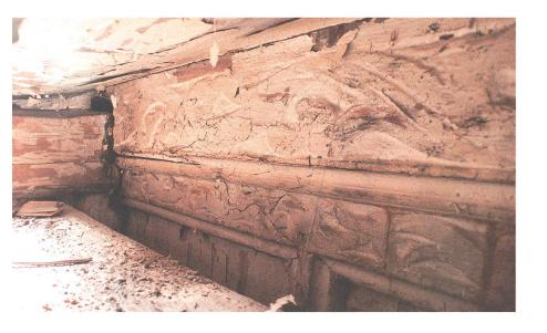
Abb. 15: Val Müstair, Kloster St. Johann in Müstair, Nordtrakt, Schlafkammer der Castelmur-Suite. Zwischenraum zwischen dem spätgotischen Täfer mit Flachschnitzereien und dem aktuellen Übertäfer.
