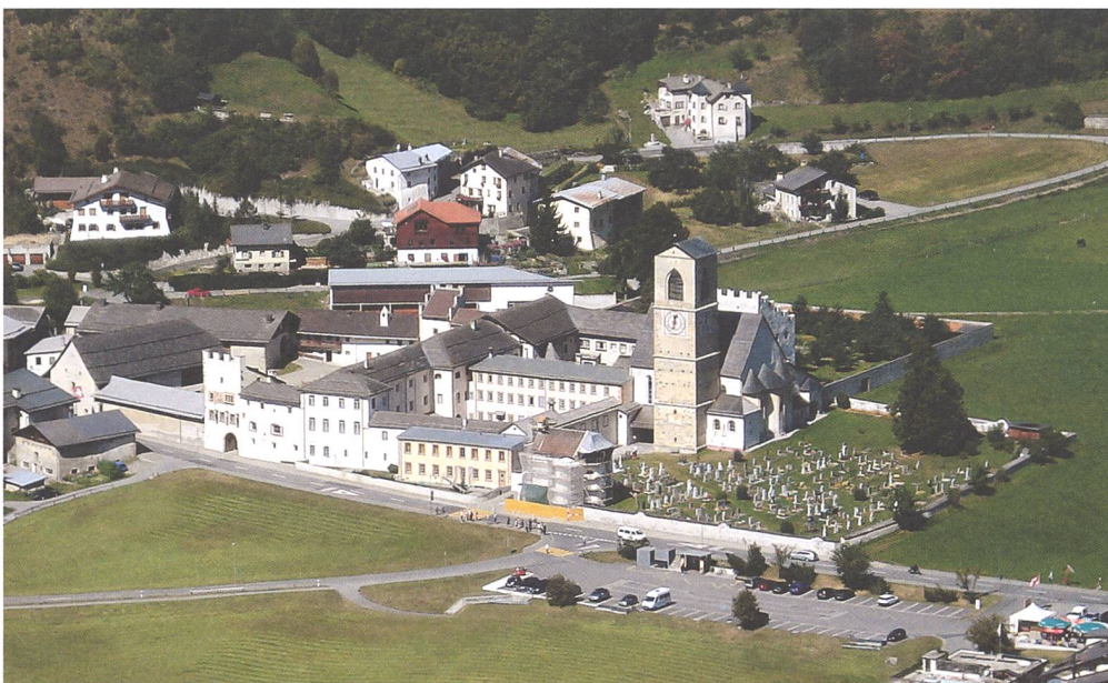
Abb. 1: Val Müstair, Kloster St. Johann in Müstair. Übersicht über die Klosteranlage mit eingerüsteter Heiligkreuzkapelle, Zustand 2009. Blick gegen Norden.
