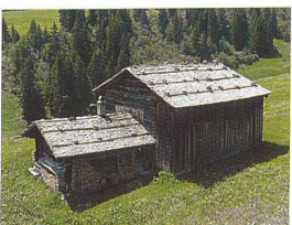
Furna Maiensässhütten und -ställe, Nr. 178, 178-A; 185, 185-A; 197, 197-A Neueindeckung Holzschindeldächer
