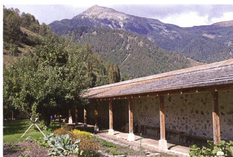
Abb. 129: Müstair, Kloster St. Johann. Nördlicher Klostersgarten. Ostteil des Laubengartens, neues Brettschindeldach.
