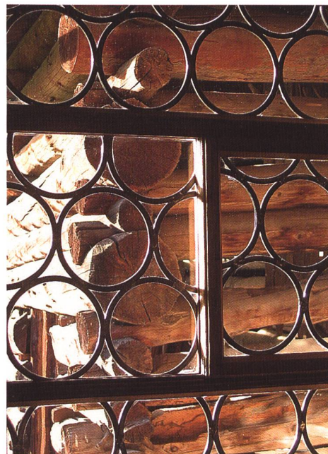
Abb. 115: Luzein, Putz, Haus Nr. 231. Das Zusammenfügen einzelner Butzenscheiben mit Bleiruten erfordert spezifische Fachkenntnis. Spezialisierte Handwerkerinnen und Handwerker bieten auch heute noch die Reparatur solcher Fensterscheiben an.
