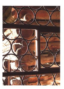
Abb. 114: S-chanf, Haus Nr. 120. Bei der Fenstersanierung wurden nur die beschädigten Teile des Fensterstocks ersetzt.
