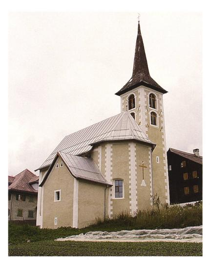
hat die Fledermaus-Expertin von einer Verschindelung des Daches abgeraten, um das Klima für die Fledermäuse nicht ungünstig zu beeinflussen. Das Turmdach liess sich mit den noch brauchbaren alten Schieferplatten des Schiffdaches reparieren, das Pultdach über dem Eingang deckte man mit Lärchenholzschindeln. Die Dächer auf Schiff, Chor und Sakristei wurden mit Blechrauten aus *Uginox* über einer sägerohen Schalung belegt.
