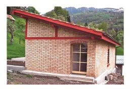
eingedeckt. Vermutlich war die Dachneigung für diese Ziegelart zu gering, so dass Wasser ins Gebäude einzudringen vermochte. Das Dach wurde nachträglich mit Herzfalzziegeln und Wellblech neu eingedeckt, womit jedoch nicht verhindert werden konnte, dass die Sparren an der Traufseite verfaulten.
