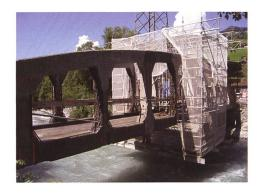
erlaubt das Vierendeel-System auch eine einfache seitliche Aussteifung der Obergurte. Quer über die Fahrbahn reichende Windverbände entfallen.
