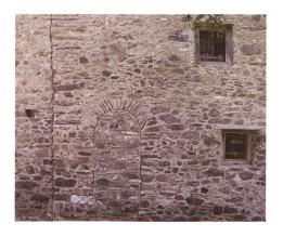
Abb. 151: Luzein, Putz, Haus Nr. 231. Vermauerter Eingang der ersten Bauphase in der Nordfassade.
