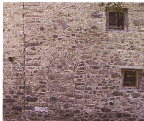
Abb. 151: Luzein, Putz, Haus Nr. 231. Vermauerter Eingang der ersten Bauphase in der Nordfassade.
