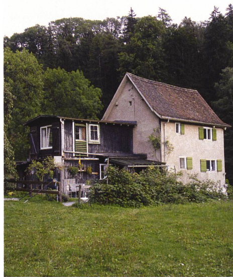
Abb. 1: Chur, Sandstrasse Nr. 19. Das Wohnhaus aus dem Jahre 1618 mit den späteren Holzanbauten vor dem Abbruch. Blick gegen Süden.
