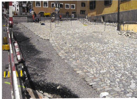
Abb. 145: Zuoz, «Plaz», während der Pflasterungsarbeiten.
