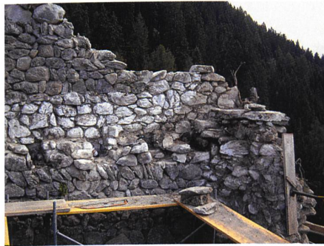
Abb. 143: Zillis-Reischen, Burgruine «Tur». Südost-ecke mit Torschwelle und Balkenauflägern des dritten Geschosses in gereinigtem Vorzustand.
