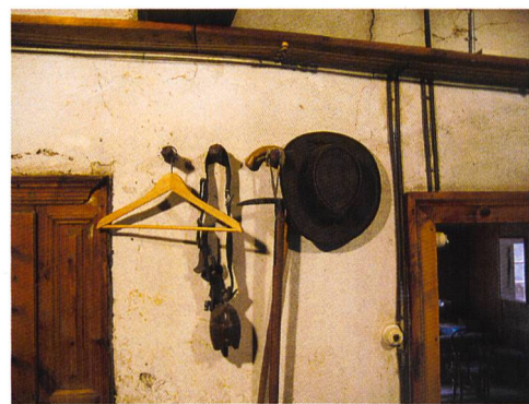
Abb. 120: Bergün/Bravuogn, Latsch, Haus Nr. 3. Elektroinstallationen der ersten Generation im Sulèr. Nachzustand.
