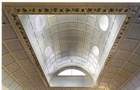
Abb. 132: Chur, Bahnhofsgedäude. Kassettierte Tonne im Zentrum der Bahnhofbuffet-Decke. Nachzustand.
