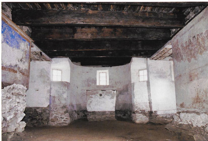
Abb. 29: Müstair, Kloster St. Johann. Heiligkreuzkapelle. Untergeschoss mit der karolingischen Balkendecke von 788. Blick gegen Osten.
