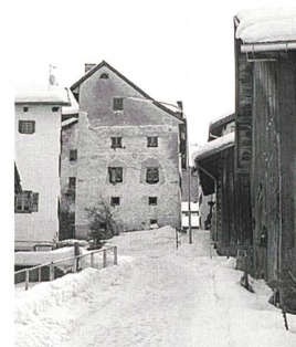
Abb. 168: Tinizong-Rona, Haus Nr. 59. Nordfassade. Aufnahme Winter 2005/06.
