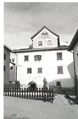
Abb. 169: Tinizong-Rona, Haus Nr. 59. Südfassade. Aufnahme Winter 2005/06.
