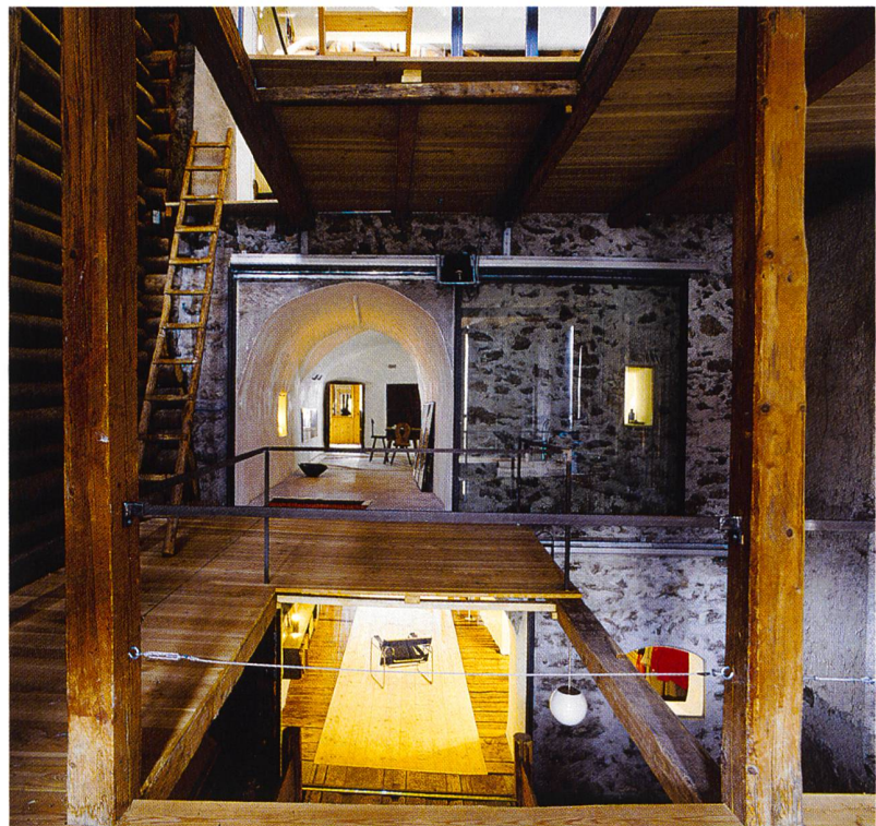
Abb. 130: Ardez, Haus Vonzun/Strimer Nr. 67/67-A. Blick aus der Scheune Richtung Wohntrakt. Nachzustand.
