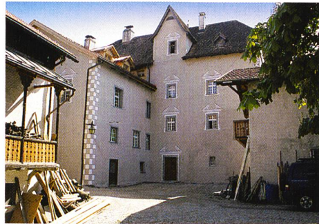
Abb. 152: Rodels, Haus von Blumenthal Nr. 20. Blick in den Hof. Nachzustand.
