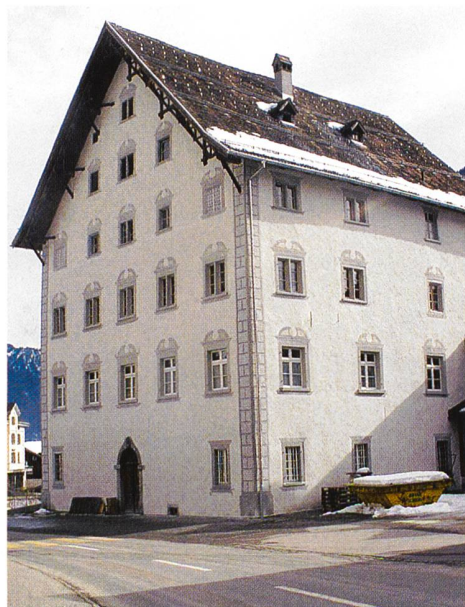
Abb. 139: Grüsch, «Grosshus»/«Hohes Haus» Nr. 414. Blick gegen Südosten. Nachzustand.
