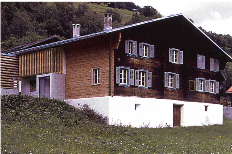
Abb. 162: Trun, Tiraun, Haus Deplazes Nr. 167. Blick gegen Nordosten.
