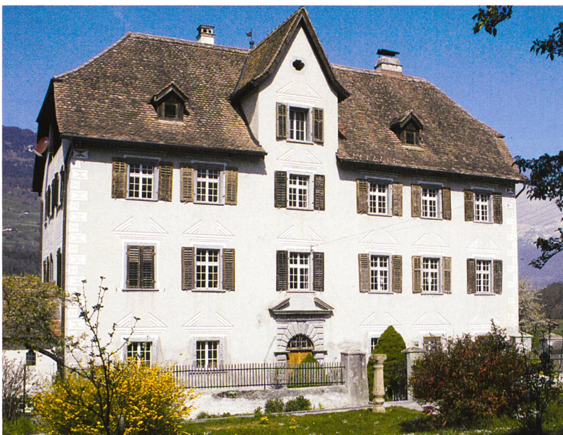
Abb. 151: Rodels, Haus von Blumenthal Nr. 20. Gar- tenfassade des Osttraktes. Nachzustand.
