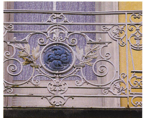
Abb. 158: Sils i. E./Segl, Hotel «Edelweiss» Nr. 53. Restauriertes Balkongeländer.
