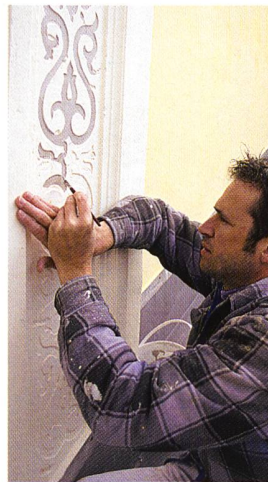
Abb. 157: Sils i. E./Segl, Hotel «Edelweiss» Nr. 53. Malerarbeiten an der Haupt- front.
