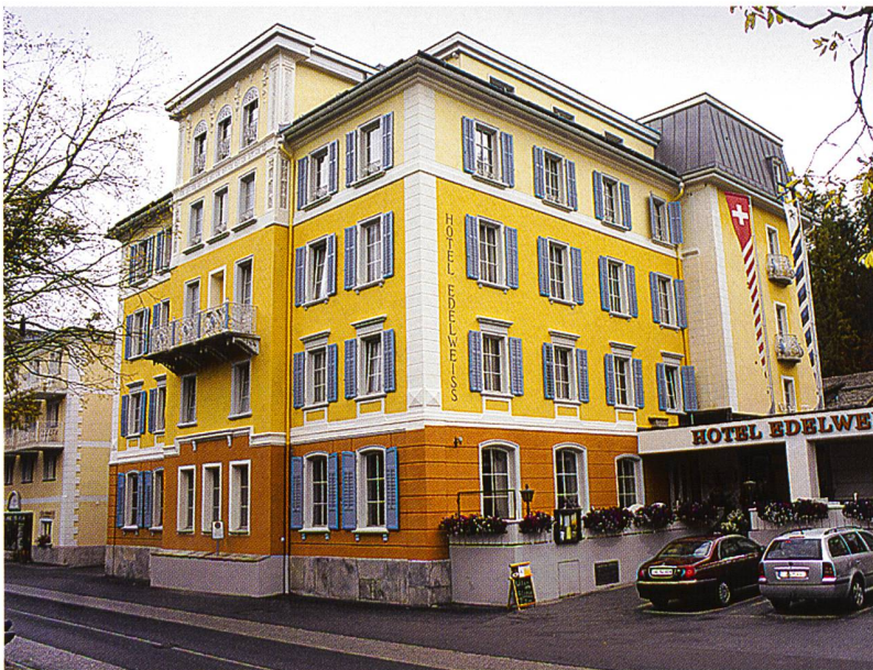
Abb. 156: Sils i. E./Segl, Hotel «Edelweiss» Nr. 53. Blick gegen Nordosten. Nachzustand.
