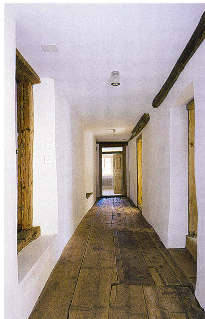
Abb. 134: Cumbel, «Scala Liunga»/«Casa Elvedi» Nr. 80. Hochparterre, Korridor. Nachzustand.
