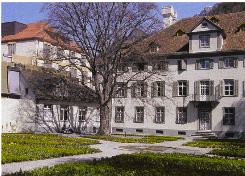
Abb. 131: Chur, Fontanapark. Blick auf die Gartenfront des «Alten Gebäus». Aufnahme Frühjahr 2007.
