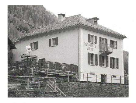
controllo della carpenteria esistente con la relativa sostituzione delle parti lignee danneggiate. La caratteristica *gronda romana* in legno è stata mantenuta. La nuova copertura in piode è stata eseguita cercando di riutilizzare il più possibile il materiale di recupero. Gli abbaini sono stati sostituiti. Tutti i lavori di lattoniere e di copertura dell'annesso, sono stati eseguiti in lamiera di zinco-titanio.
