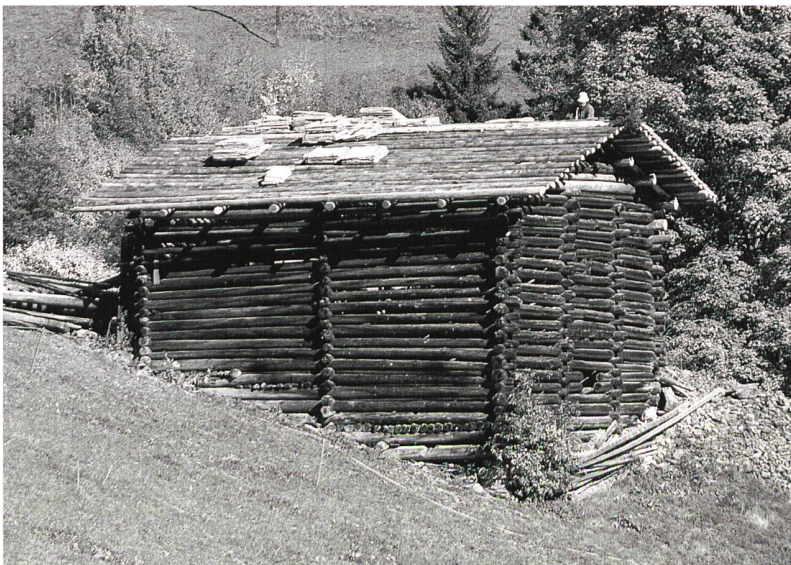
Abb. 146: Peist, Barge Nr. 57. Erneuerungsarbeiten am Schindeldach. Blick gegen Nordosten.
