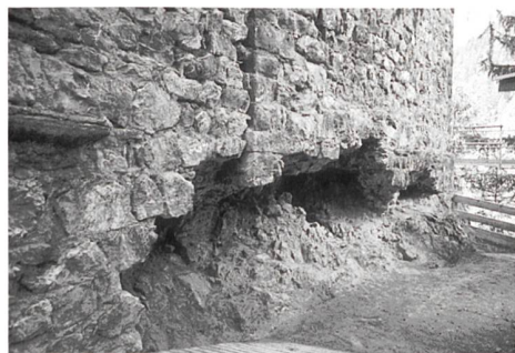
Abb. 107: Brienzenz/Brinzauls, Burganlage Belfort. Die 1499 unterminierte Nordfassade des Hauptturms.
