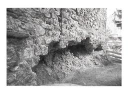
Abb. 107: Brienz/Brinzauls, Burganlage Belfort. Die 1499 unterminierte Nordfassade des Hauptturms.
