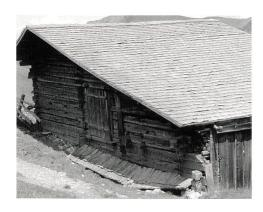
Abb. 96: Safien, Zalön, Alpstall/Einzelsennerei (Stupli). Nachzustand des Schindeldaches. Blick gegen Nordosten.
