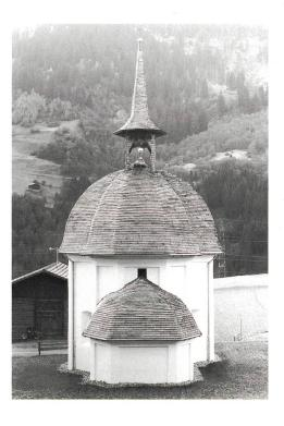
werden die zwecks Ausdehnung zuvor in Wasser getränkten Schindeln seitlich aneinander gestossen und genagelt. Man nennt diese Verlegeart auch einen *gestossenen Schirm*.
