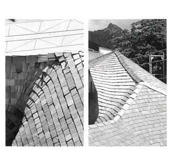
Abb. 92: Bever, evangelisch-protestantische Kirche. Schindeldach, Kehlausbildung (links); Tarasp, Schloss Tarasp. Schindeldach Wehrgang, First- und Gratabschluss (rechts).
