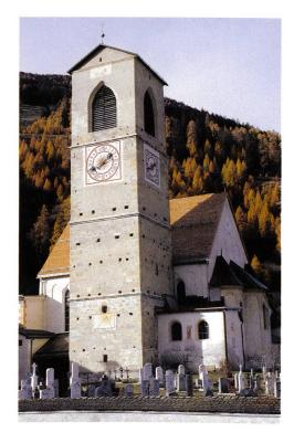
mit dem spätgotischen Dachaufbau erhöhten Giebelfassaden der Klosterkirche abgewittert waren. Mit beträchtlichem Aufwand wurden Hohlstellen hintergossen und Löcher mit Sumpfkalkmörtel gefüllt. Zudem wurden beide Giebelfronten mit einem neuen, abgetönten Kalkanstrich versehen, der als Verschleissschicht die originalen, karolingischen und spätgotischen Verputze schützt.
