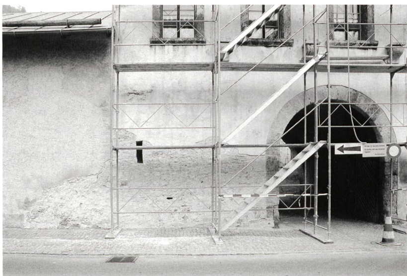
Abb. 36: Müstair, Kloster St. Johann. Südtrakt, Südtorturm, Südfassade. Entmörtelte Sockelpartie. Blick gegen Norden.
