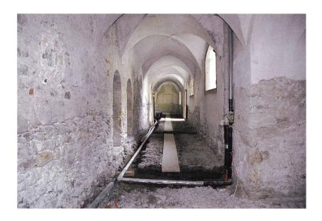
Abb. 32: Müstair, Kloster St. Johann. Nordtrakt, Erdgeschoss, Kreuzgang 11n. Übersicht über den Kreuzgang nach Entfernen der schadhaften Sockelputze und der Betonkanäle. Blick gegen Osten.
