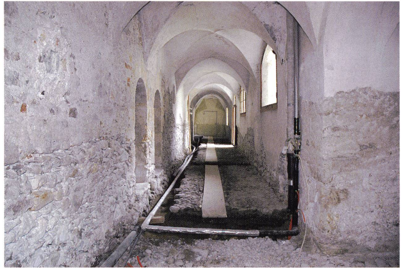
Abb. 32: Müstair, Kloster St. Johann. Nordtrakt, Erdgeschoss, Kreuzgang 11n. Übersicht über den Kreuzgang nach Entfernen der schadhafte Sockelputze und der Betonkanäle. Blick gegen Osten.
