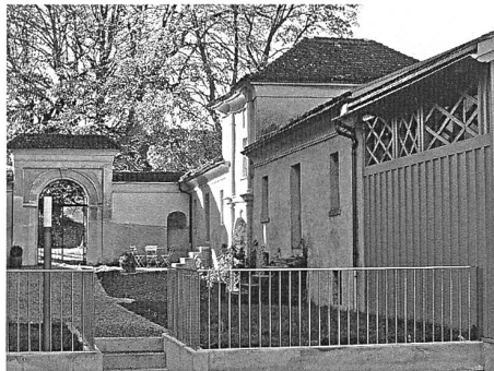
Abb. 147: Zizers, Oberes Schloss, Portalhaus und Gartentor. Blick gegen Süden.
