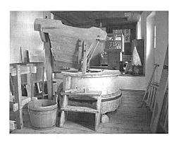
Abb. 149: Sta. Maria V. M., Mühle Mall, Erdgeschoss. Mahlgang mit Läufer- und Bodenstein, darüber der Einfülltrichter.
