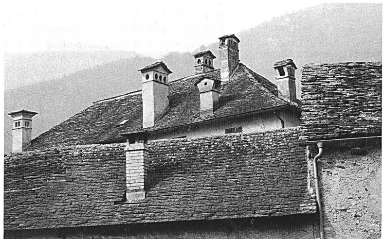
Abb. 119: Roveredo, Haus Toveda. Steinernes Walmdach mit Kaminen.
