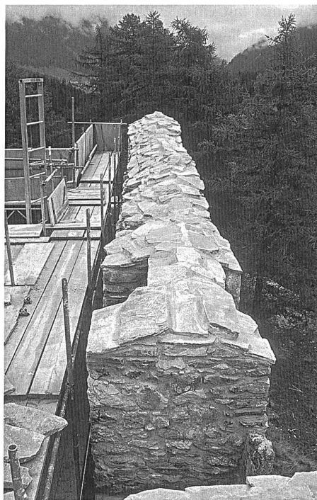
Abb. 96: Splügen, Ruine «Zur Burg». Palas, Südmauer. Neue, dachförmige Abdeckung der Mauerkrone. Blick gegen Osten.
