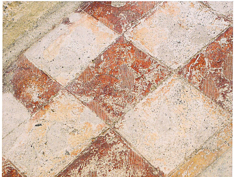
Abb. 79: Chur, Kathedrale St. Mariä Himmelfahrt, Altarhaus, Ostwand. Neue Kittungen und Trateggio-Retuschen in den Rotbereichen des Giebfrieses.
