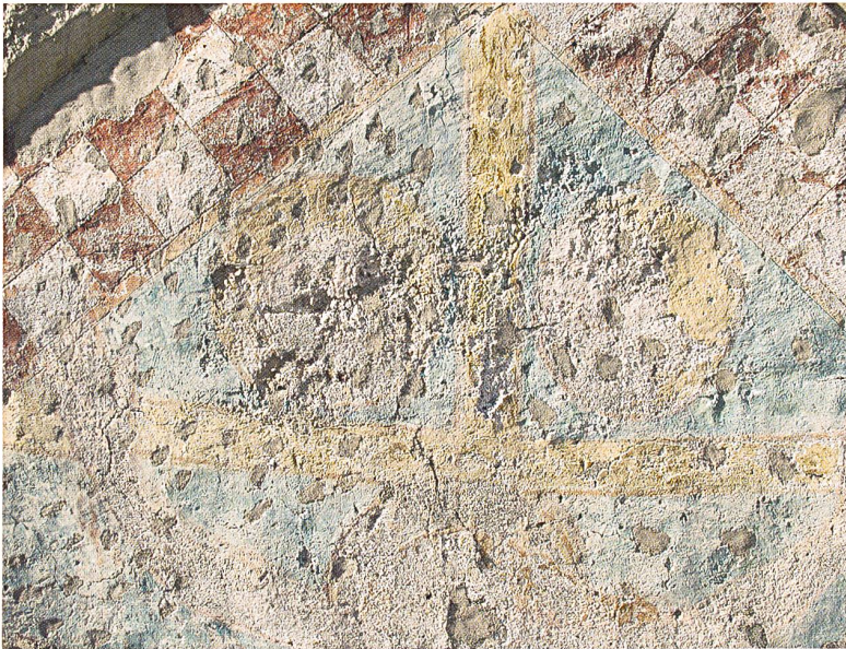
Abb. 77: Chur, Kathedrale St. Mariä Himmelfahrt, Altarhaus, Ostwand. Detail des Kreuzigungsbildes mit Kittungen von Restaurator Franz Xaver Sauter aus dem Jahre 1957.
