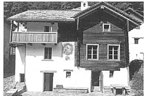
Abb. 63: Soazza, Casa San Floriano Nr. 111. Restaurierte Hauptfassade.
