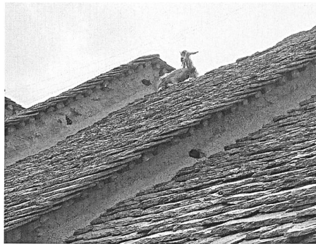
Abb. 175: Medel (Lucmagn), Alp Stgegia. Detail des Steinplattendachs auf dem Genossenschaftsstall.
