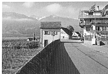
Abb. 164: Jenins, Rebhaus Nr. 62. Ansicht von Süden.
