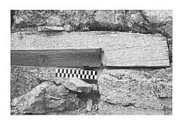
lichen Leibungen war dieser 12 cm breite und tiefe Anschlag gemauert, an den hölzernen Stürzen war er ins Holz eingetieft (Abb. 135). Er diente der Aufnahme eines Ladens, welcher – am Sturz befestigt – aufgeklappt werden konnte. Liess man den Klappladen los, schloss sich dieser durch sein eigenes Gewicht. An diesen Fenstern konnten Armbrustschützen die Angriffsseite überwachen.
