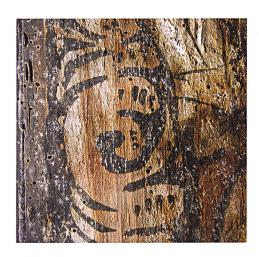
ger von Pilz befallen sind als die übrigen (Abb. 127 und 128). Daraus kann geschlossen werden, dass das Mehr an Licht und Luftbewegung das Wachstum der Pilze an der Decke hemmt.
