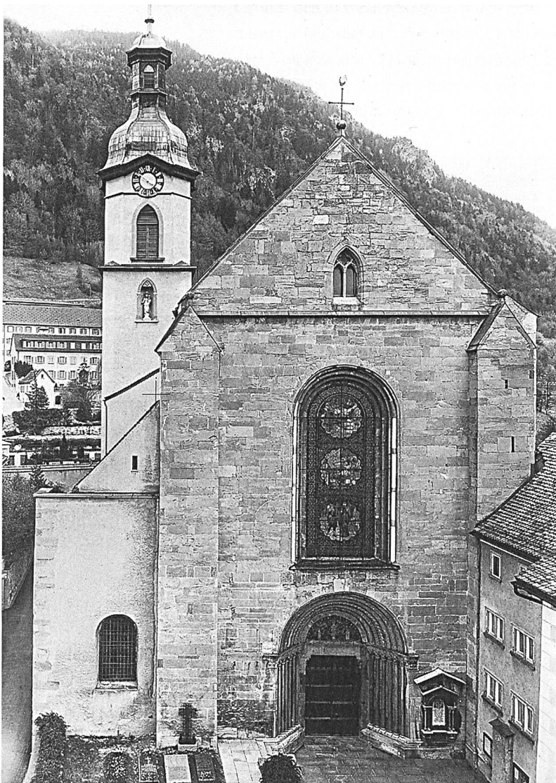
Abb. 116: Chur, Kathedrale St. Mariä Himmelfahrt, Westfassade. Zustand 2002, vor der Konservierung.
