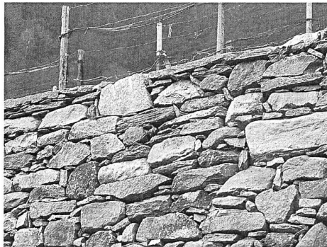
Abb. 106: Verdabbio, restaurierte Trockenmauer.
