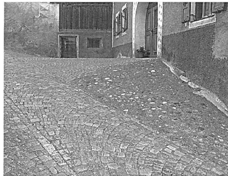
Abb. 263: Tschlin, Aussenräume. Die verschieden grossen Pflastersteine der ehemaligen Hauptstrasse kamen nach der Sanierung an der gleichen Stelle wieder zur Verwendung.
