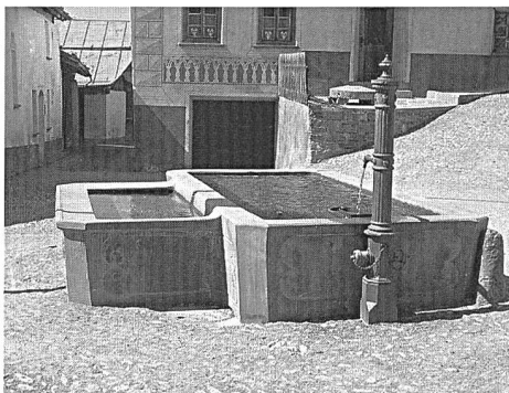
Abb. 264: Tschlin, Aussenräume. Die Brunnenröge aus Beton von 1905 haben durch die Restaurierung den ursprünglichen Charakter zurückerhalten. Der Brunnenstock dient gleichzeitig als Hydrant.
