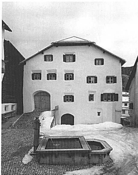
Abb. 250: Ardez, Haus Nr. 69. Platzfassade.
