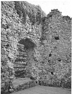
In Phase 3 wird mit dem Bau der Westmauer als westlicher Hofbegrenzung auch die Umfassungsmauer der Anlage vervollständigt (Abb. 208). Die westliche Hofmauer wurde in einer Breite von 1,50 m errichtet, darüber ein 1 m breiter Wehrgang mit einer 50 cm starken und 1 m hohen Brüstungsmauer erstellt. Letztere war mit gegen aus-
