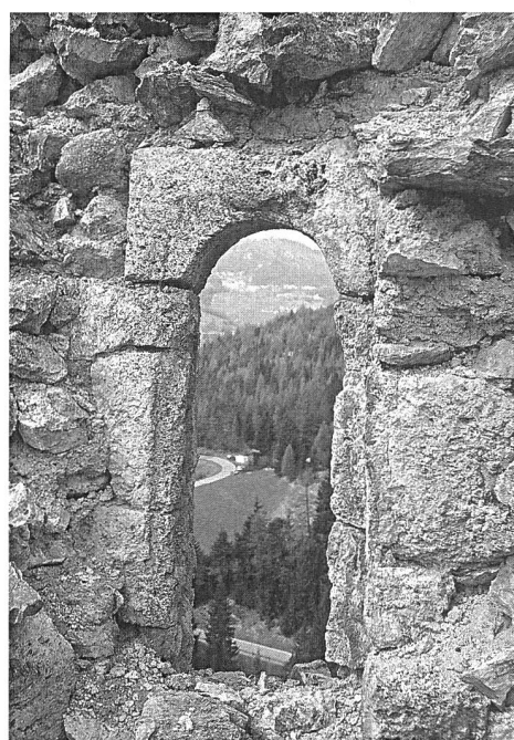
Abb. 211: Brienzen/Brinzauls, Burgruine Belfort. Südtrakt, West-Innenwand, Rundbogenfenster in Tuffstein zu Saal im vierten Geschoss. Ansicht von Osten.
