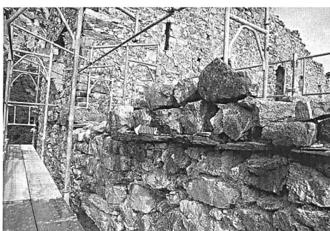
Abb. 213: Brienzen/Brinzauls, Burgruine Belfort. Westfassade, vorkragender Steinplattenkranz in der jüngsten Aufhöhung. Ansicht von Südwesten.
