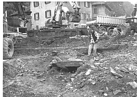
Abb. 142: Sils i.D., Sanierung Hauptstrassen. Freilegung des Abwasserkanals unmittelbar nördlich des Dorfbrunnens. Blick von Norden.
