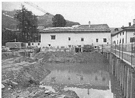
Abb. 152: Sils i. E./Segl, Baselgia/nördlich Haus Suosta Veglia. Baugrube nach Anstieg des Grundwasserspiegels. Blick von Norden.
