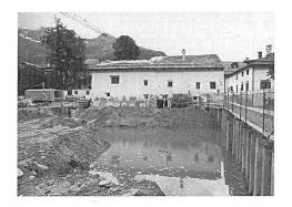
Abb. 152: Sils i. E./Segl, Baselgia/nördlich Haus Suosta Veglia. Baugrube nach Anstieg des Grundwasserspiegels. Blick von Norden.
