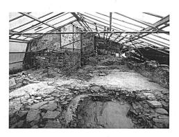
schadhafte Partien im Mörtelboden ausgegossen und das Bodenniveau des Chors um Stufenhöhe angehoben worden.
