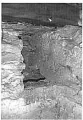
Abb. 29: Müstair, Kloster St. Johann. Befunddetails in der Nordostecke der Kirche: Im linken Bild die Negative der überkämmten Ankerbalken, gegen Süden. Im rechten Bild ein Blick gegen Nordosten in die Fehlstelle des karolingischen Deckenbalkens. Der Schatten fällt in die Vertiefung des nördlichen Ankerbalkennegativs. Der Grundputz an den Innenwänden stiess gegen den Deckenbalken, der Malereiputz schloss an die Dekkenbohlen an.
