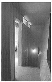
Abb. 171: Zuoz, Haus Nr. 119. Wohnung B, Dachgeschoss. Einfache architektonische Mittel wie die hier gezeigte, mit Stülpschalung verkleidete schräge Wand und gezielter Lichteinfall lassen die engen Raumverhältnisse grösser erscheinen.
