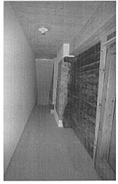
Abb. 170: Zuoz, Haus Nr. 119. Wohnung A, Obergeschoss. Der Strickbau der Kammer im Obergeschoss ist im Innern wieder sichtbar.
