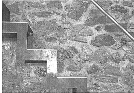
Abb. 164: Splügen, Herberge Weisses Kreuz. Detail der neuen Treppe.
