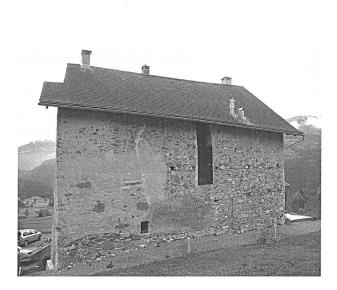
Abb. 135: Brienz/Brinzauls-Vazerol, Tgesa Gronda. Der neue Zugang von Norden in die Wohnung des zweiten Geschosses. Als Material wurde Eisen gewählt, um den Eingriff in die historische Substanz lesbar zu machen. Die den Eingang erschliessende Aussentreppe fehlt noch.
