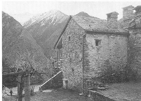
Abb. 152: Castaneda, Haus Nr. 33. Ansicht von Norden.
