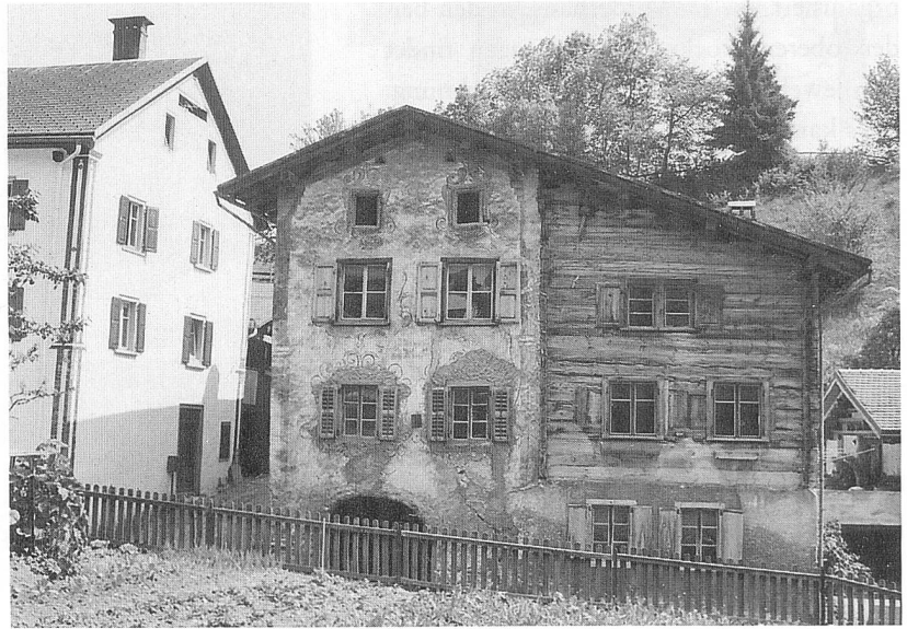
Abb. 149: Trin, Haus Nr. 34. Nordfassade, Vorzustand.
