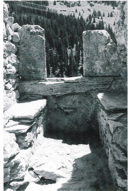
Abb. 131: Burg Splügen. Fenster mit Sitznische in der Südwand des dritten Geschosses.
