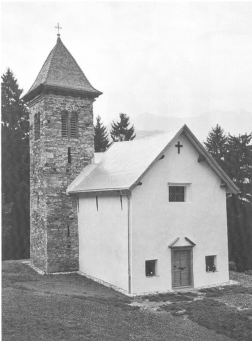
Abb. 120: Rueun-Gula, Kapelle St. Maria Magdalena (Sontga Maria Madleina). Ansicht von Nordwesten, Zustand nach der Restaurierung.
