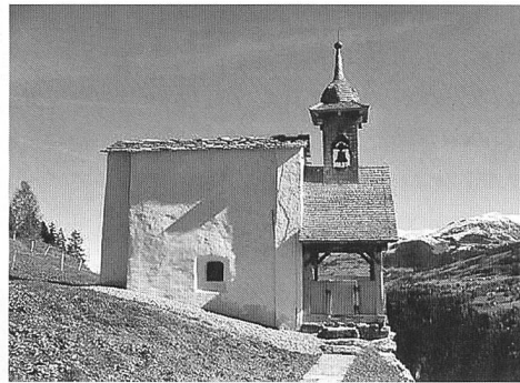
Abb. 115: Dardin-Pugaus, Kapelle St. Nikolaus (Sontga Clau). Südwestseite nach der Restaurierung mit neuem Steinplattendach auf Chor und Schiff und Schindeldach auf Vorzeichen und Dachreiter.
