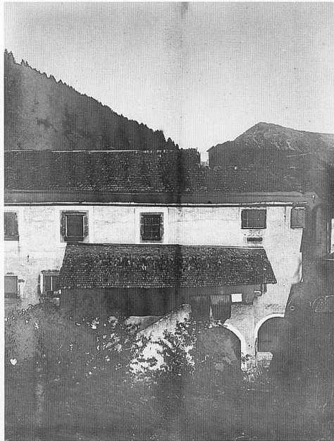
Abb. 111: Müstair, Kloster St. Johann, Nordhof. Treppe aus dem 16. Jh. von Süden, um 1910.
